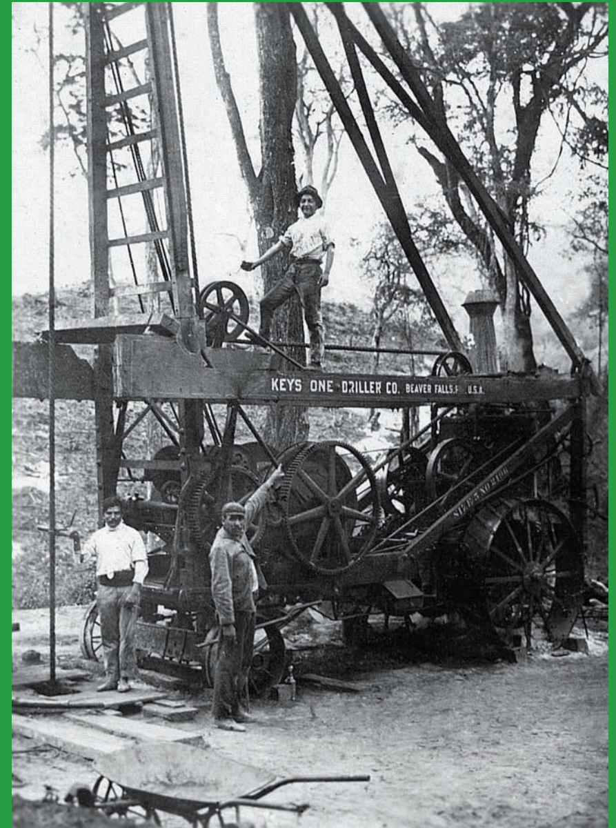
Operarios de una perforadora portátil Keystone en la Cca. Noroeste.
