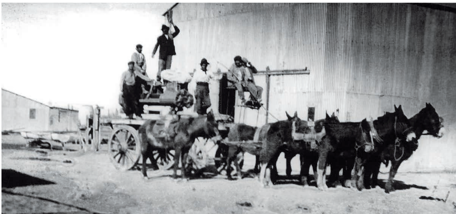
Arriba: traslado de una perforadora y su caldera a leña, remolcada por un tractor. Abajo: la tracción a sangre fue, durante décadas, la única forma de llevar los equipos hasta los yacimientos. En la imagen, Plaza Huincul, Cca. Neuquina.
