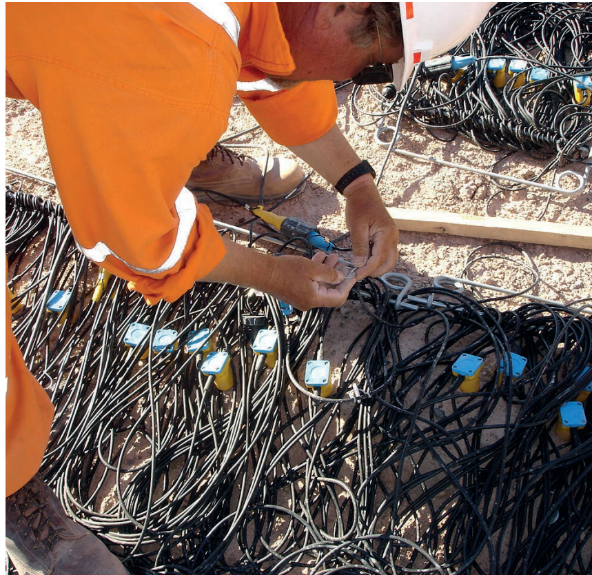
Preparación de los instrumentos para estudios de sismica onshore .
